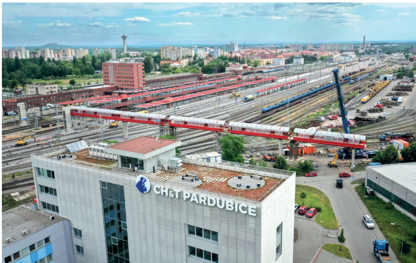
Sídlo firmy CH&T Pardubice a v pozadí probíhající práce na Modernizaci uzlu Pardubice vč. lávky pro pěší.
