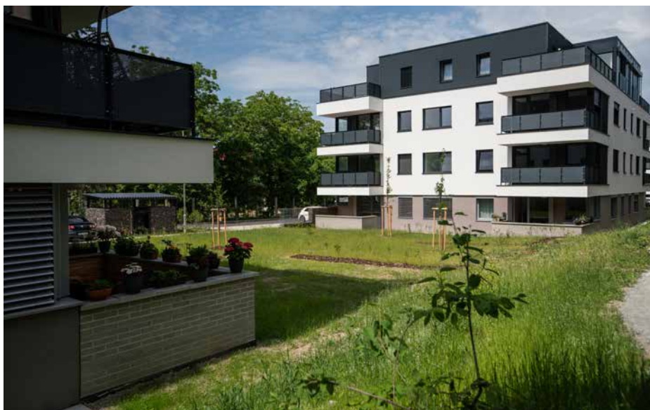
▲ Obr. 6 Stavba bytových domů Mírová v Dobrušce, stav po dokončení, květen 2023
